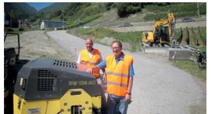
Sébastien Lonfat et Bertrand Huguet, du Service valaisan de la mobilité, devant la route de déviation en cours de réalisation au bas du col de La Forclaz. LE NOUVELLISTE
