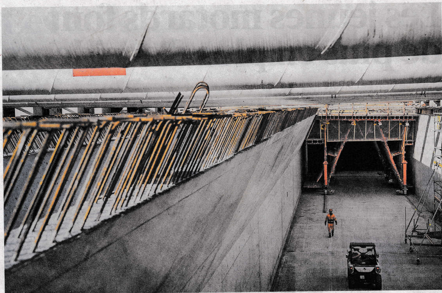
Sur les tronçons haut-valaisans de l'autoroute A9, les chantiers vont bon train, comme ici en novembre 2021... mais le bout du tunnel paraît encore bien loin. Keystone/Jean-Christophe Bott
